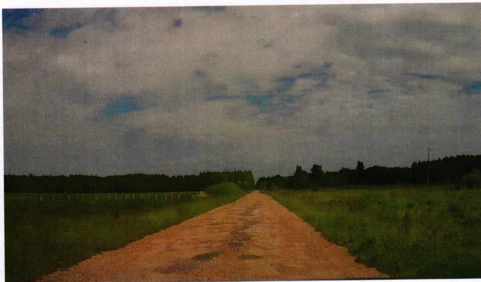
Droga 1262B przed przebudową
