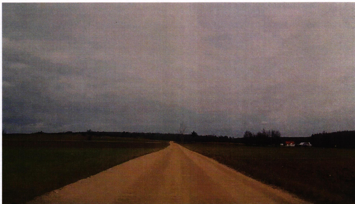
Droga nr 1266B przed przebudową
