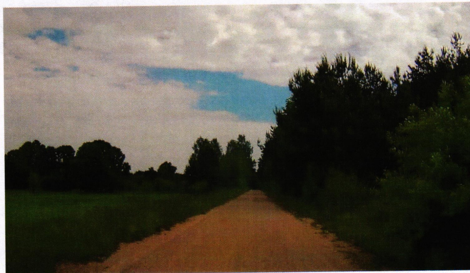
Droga 1262B przed przebudową
