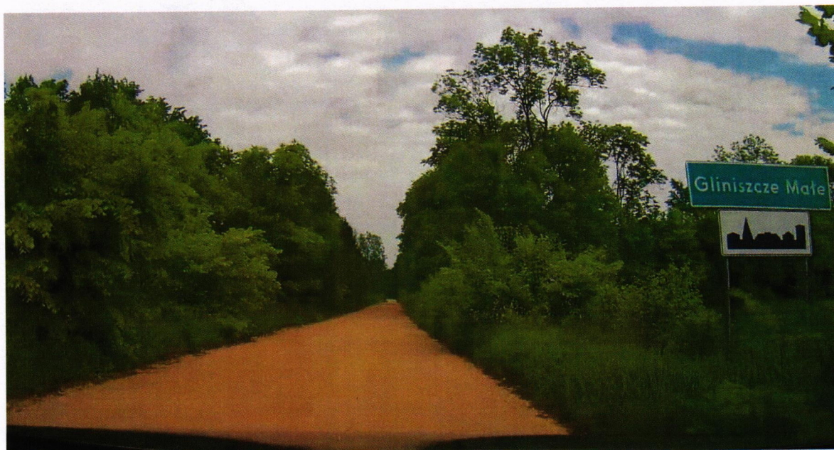
Droga nr 1262B przed przebudową
