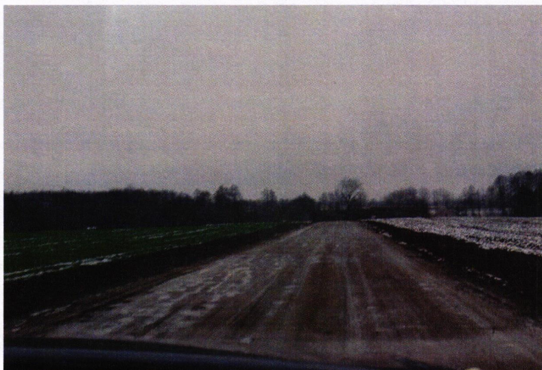
Droga 1243B przed przebudową
