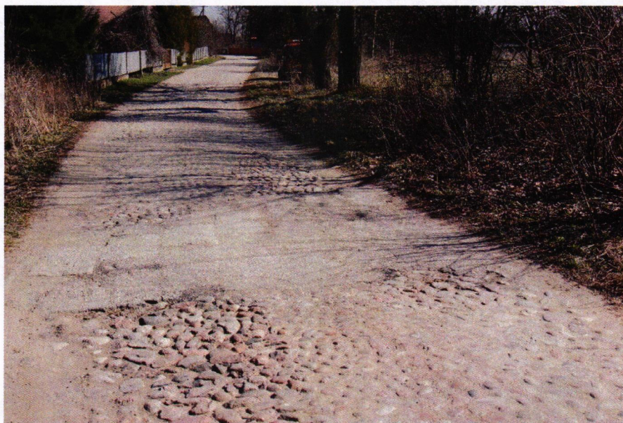
Droga 1289B przed przebudową
