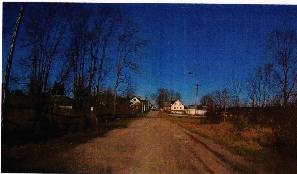
Droga 1261B przed przebudową
