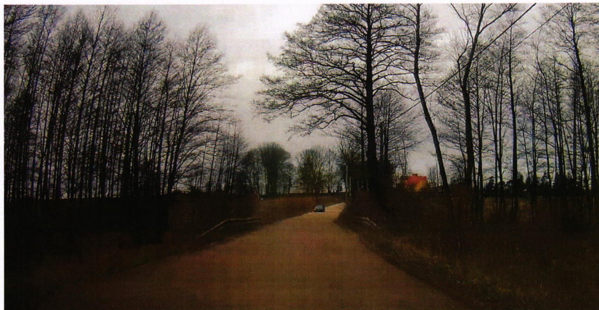
Droga nr 1266B przed przebudową
