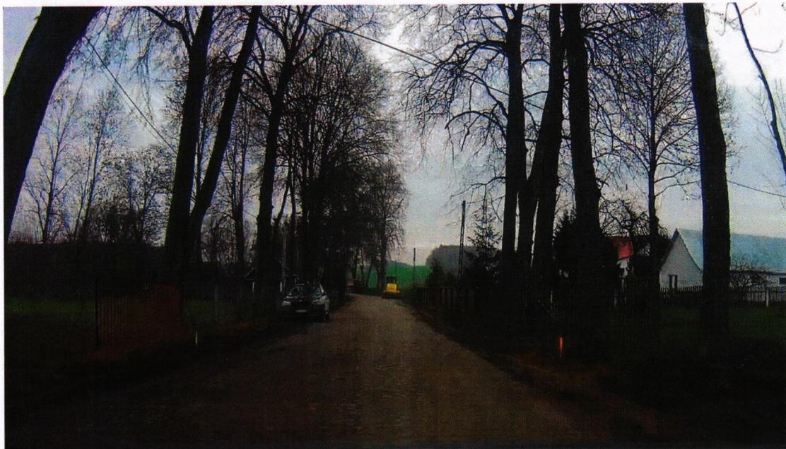
Droga 1270B przed przebudową
