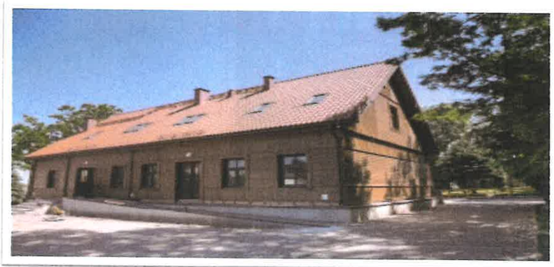
Budynek po wykonanych pracach budowlanych
