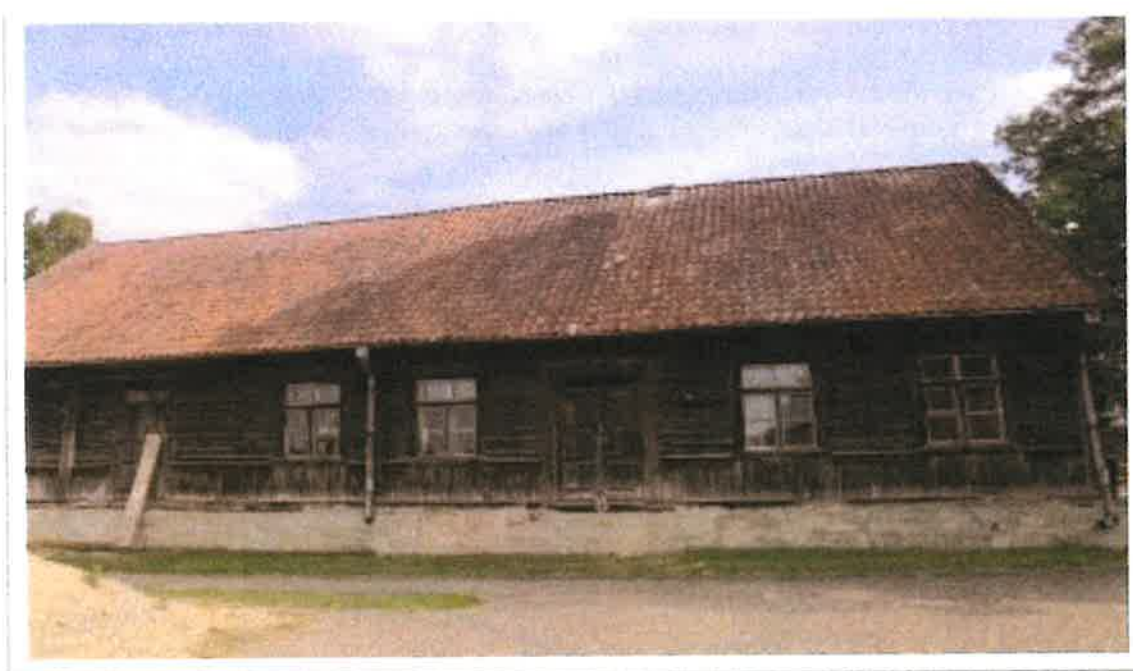
Obiekt przed przebudową
