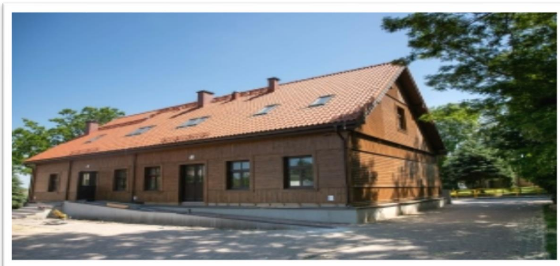
Budynek po wykonanych pracach budowlanych
