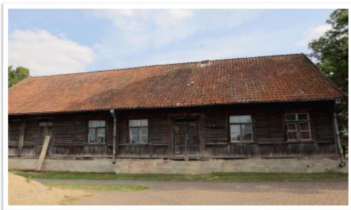
Obiekt przed przebudową
