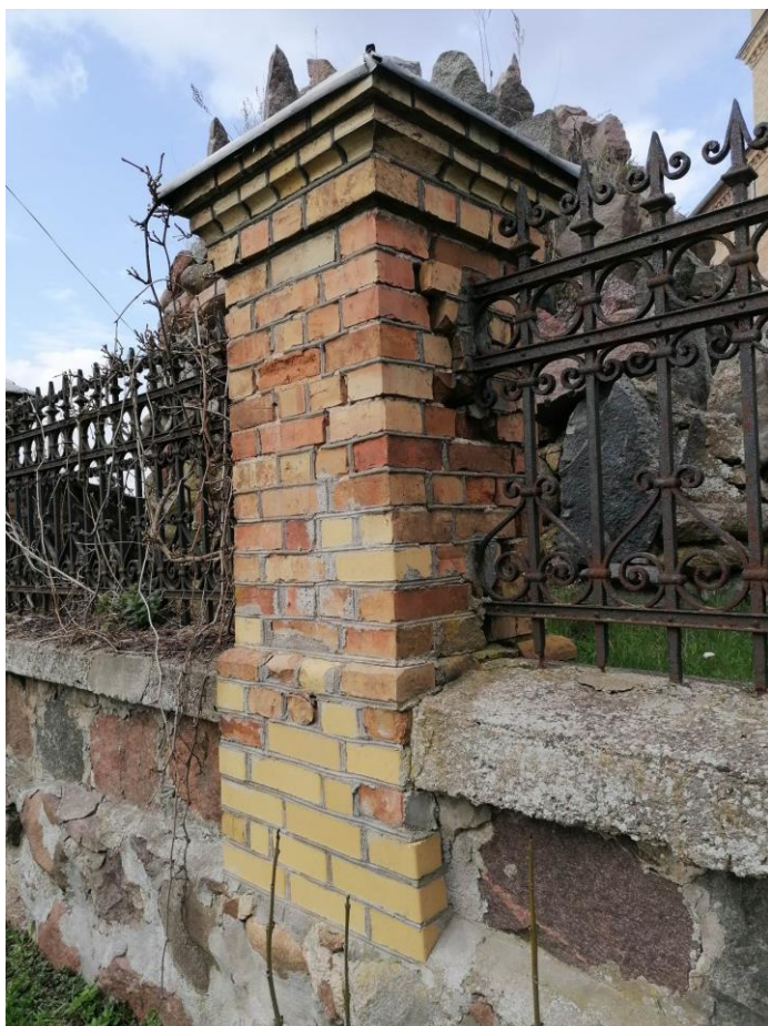
Fot. nr 9- Ubytki w murze (płd- zachd)
