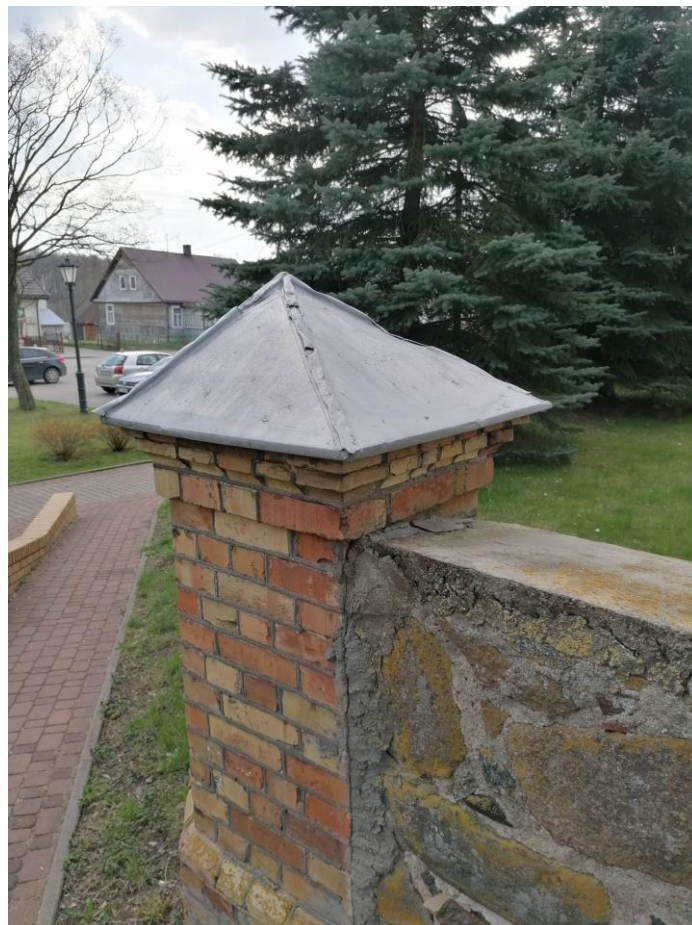
Fot. 10- Uszkodzone obróbki blacharskie (płd- wsch).
