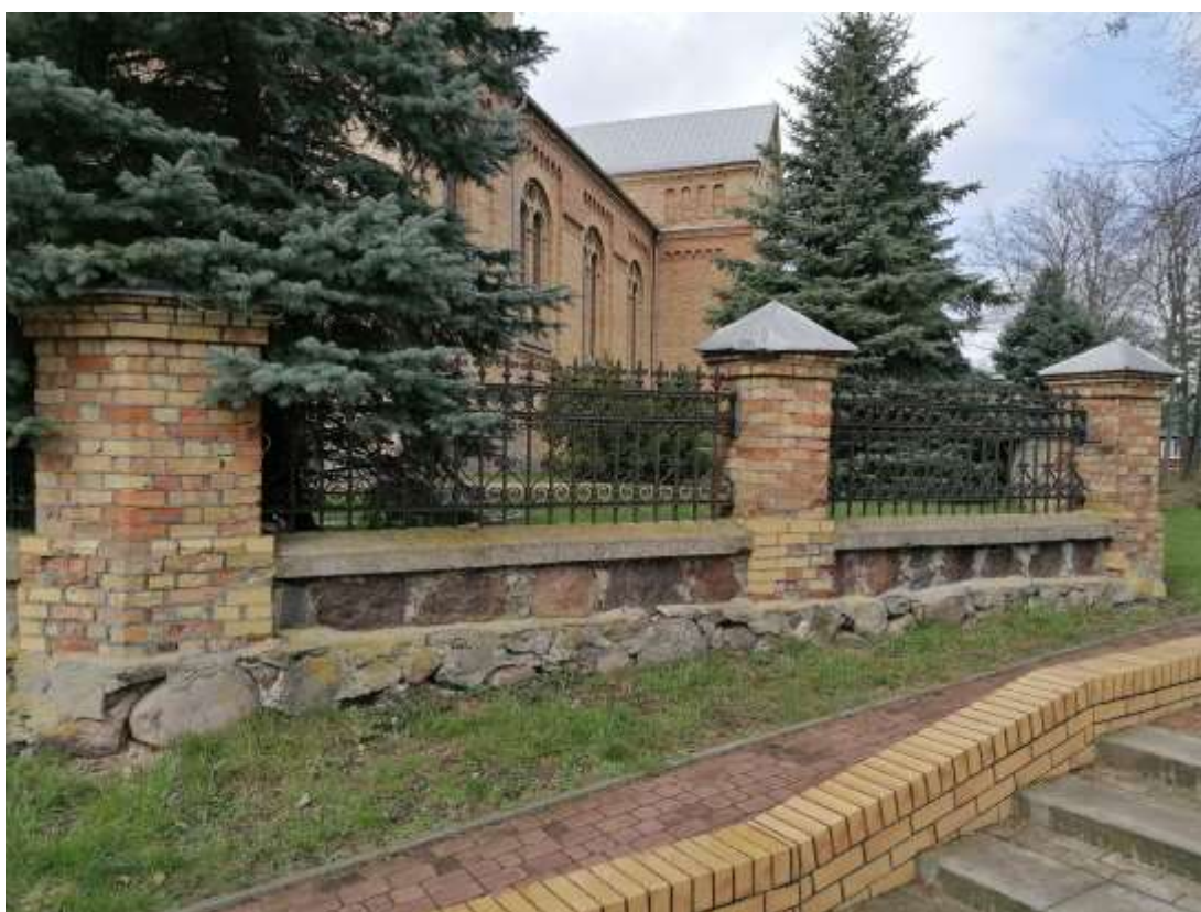
Fot. nr 5- Fragment ogrodzenia od strony południowo- wschodniej
