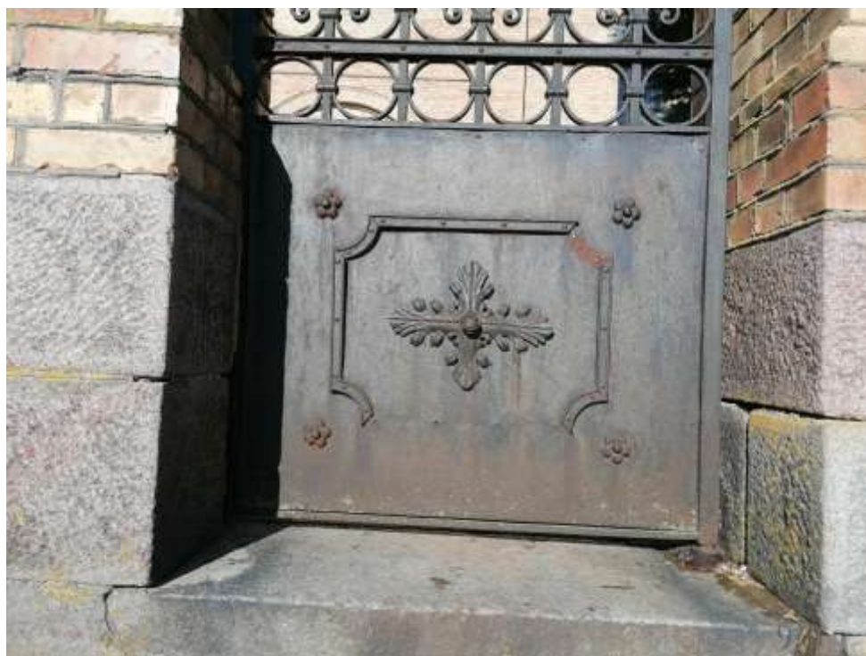
Fot. nr 12- Dolna część wrót wejściowych- wejście główne.
