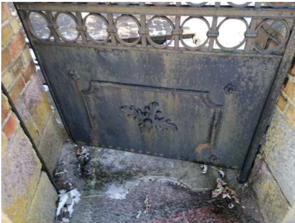
Fot. nr 11- Dolna część wrót wejściowych- wejście główne.
