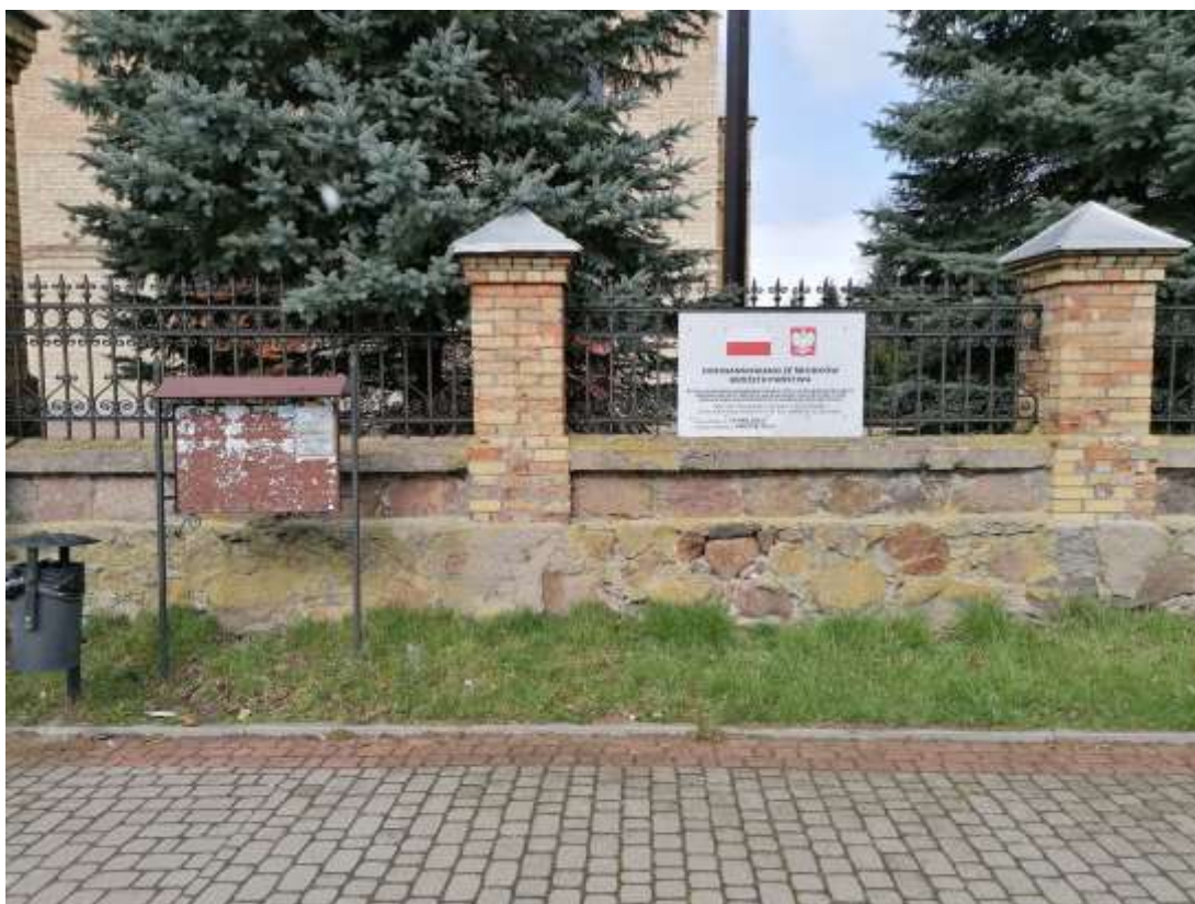
Fot. nr 4- Fragment ogrodzenia od strony południowo- wschodniej
