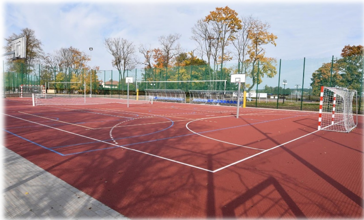
Nowoczesny obiekt sportowy przy Zespole Szkół Zawodowych im. Elizy Orzeszkowej w Sokółce
