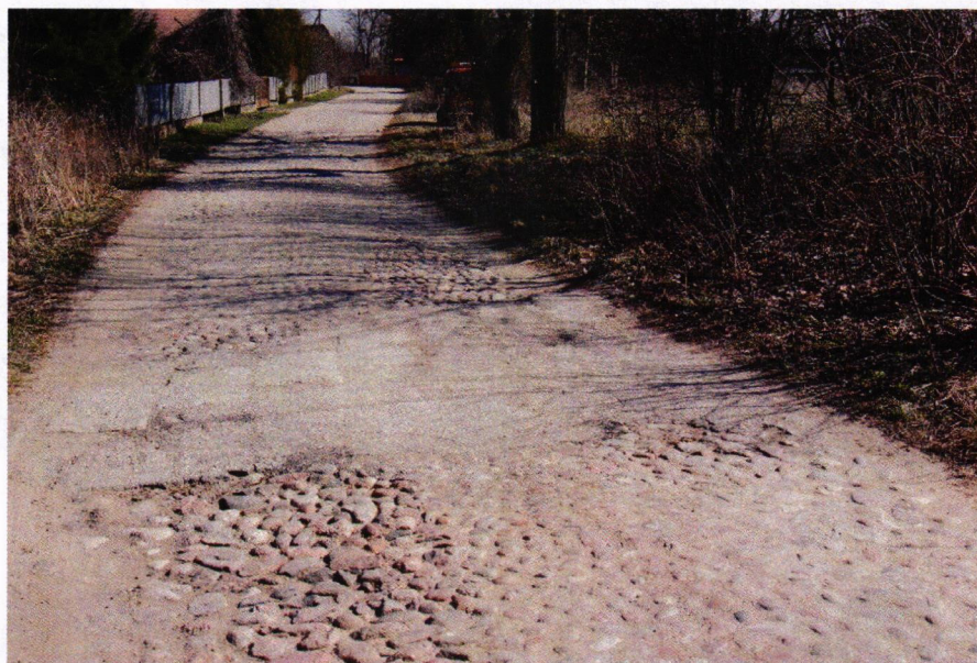
Droga 1289B przed przebudową
