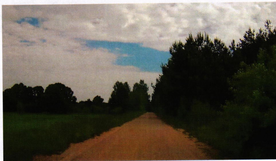
Droga 1262B przed przebudową
