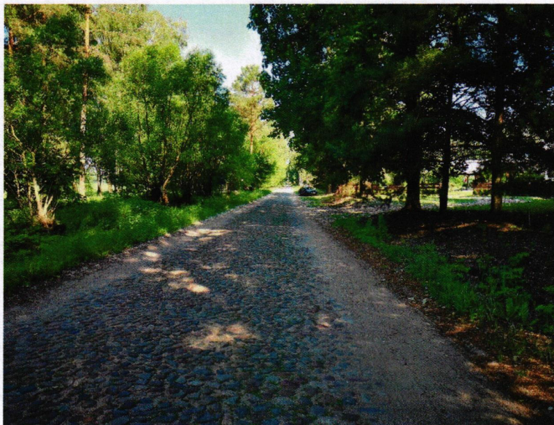
Droga 1307B przed przebudową
