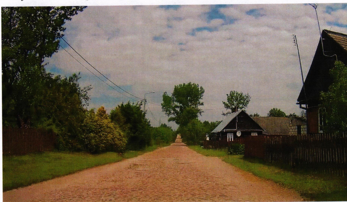
Droga nr 1262B przed przebudową
