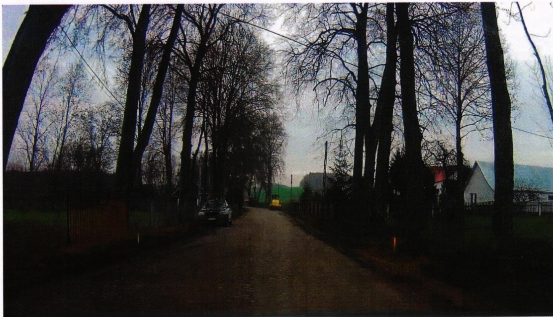
Droga 1270B przed przebudową
