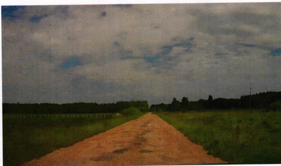
Droga 1262B przed przebudową
