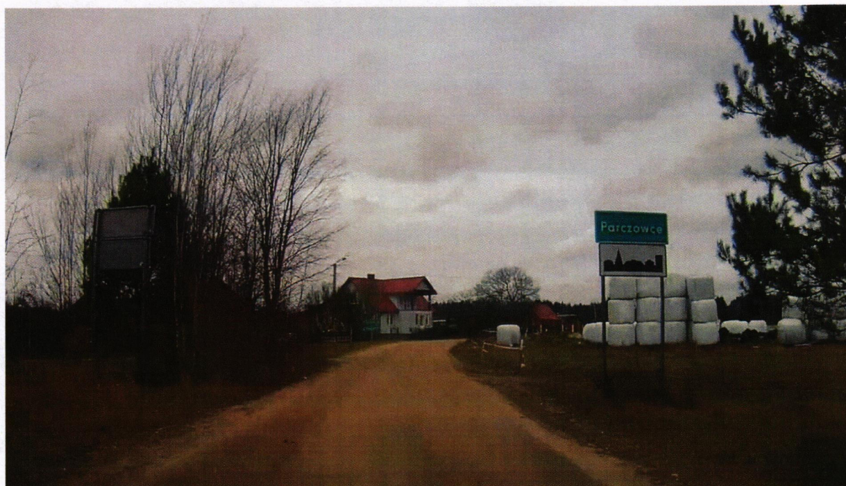
Droga nr 1266B przed przebudową
