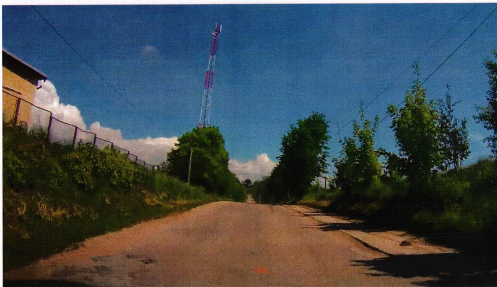
Droga 1249B – ulica Sidrzańska przed przebudową
