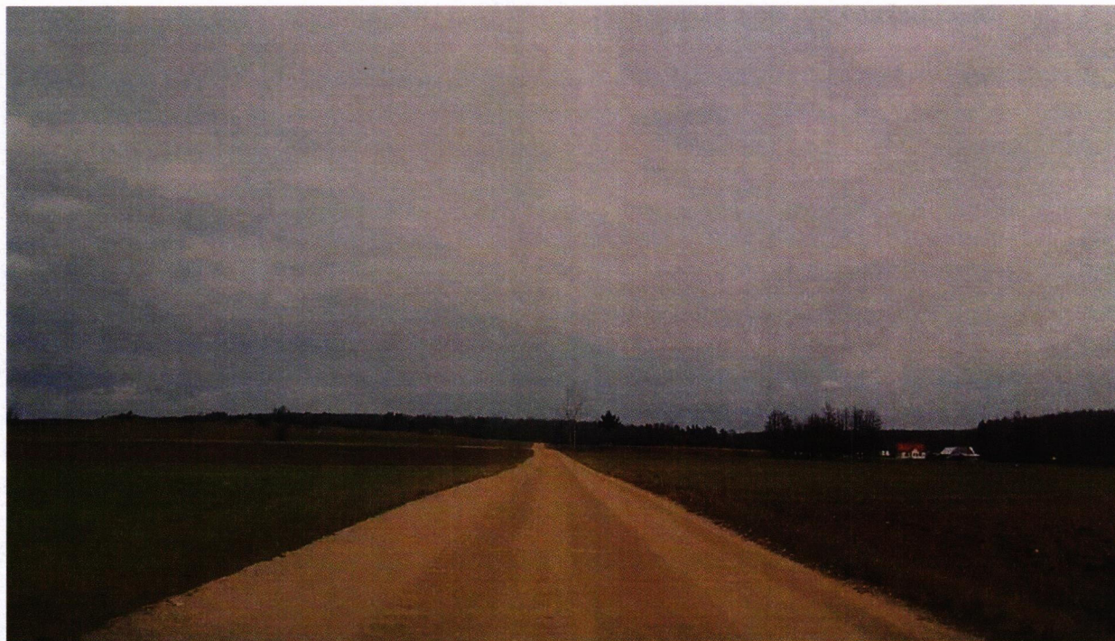
Droga nr 1266B przed przebudową
