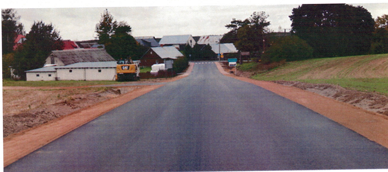
Droga nr 1247 B po przebudowie
