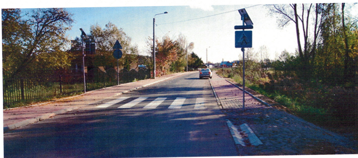
Droga nr 1304 B po przebudowie
