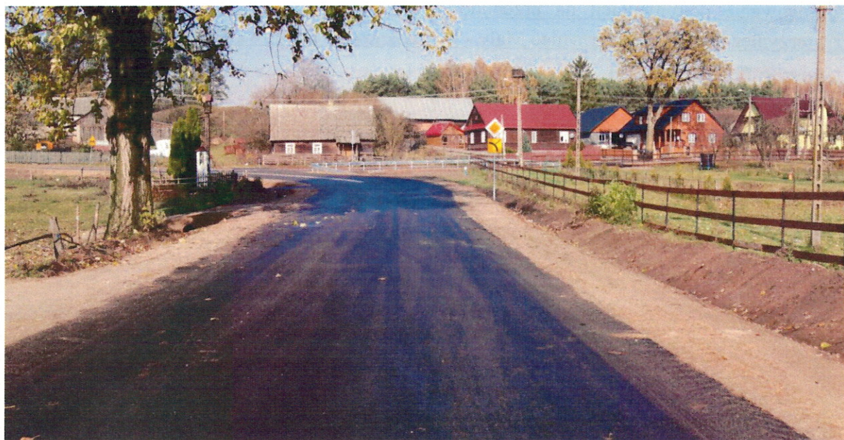
Droga nr 1305B po przebudowie
