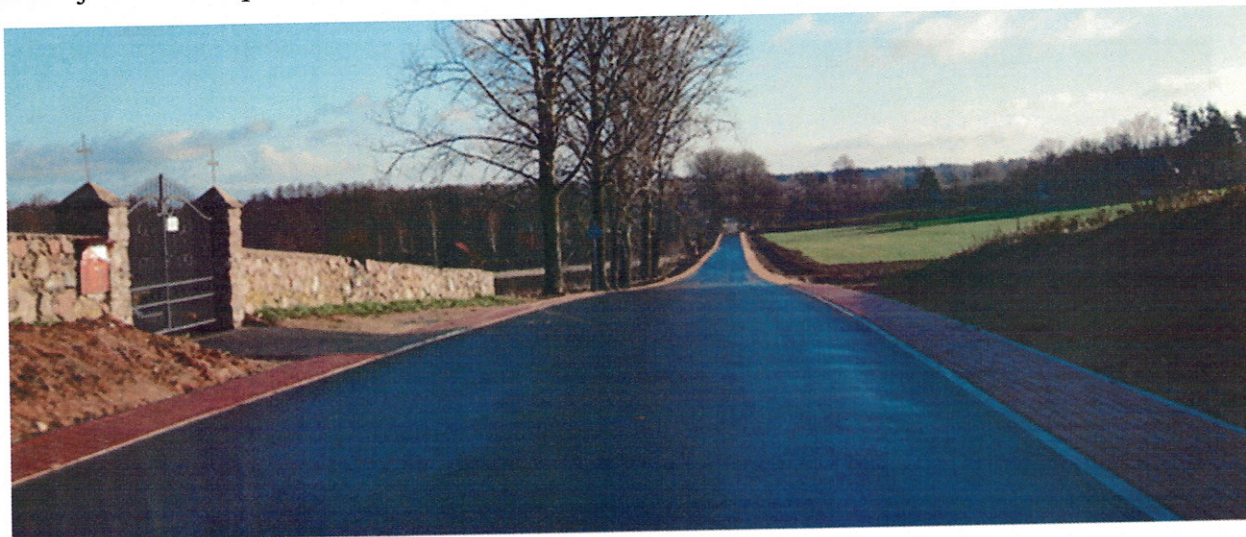
Droga nr 1273B po przebudowie
