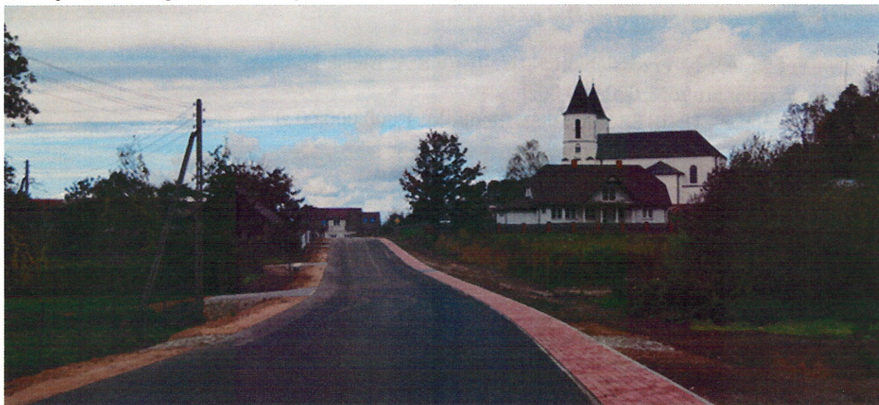
Droga nr 1259B po przebudowie
