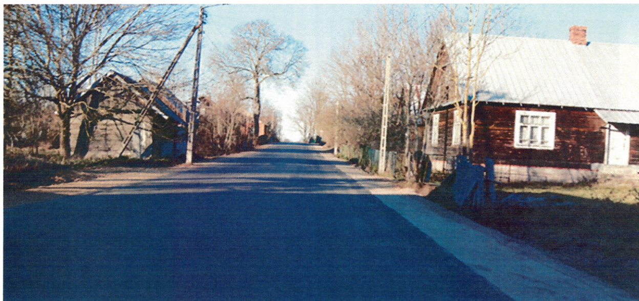
Droga nr 1267B po przebudowie
