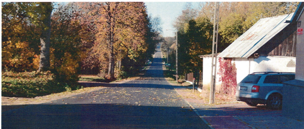
Droga nr 1254B po przebudowie
