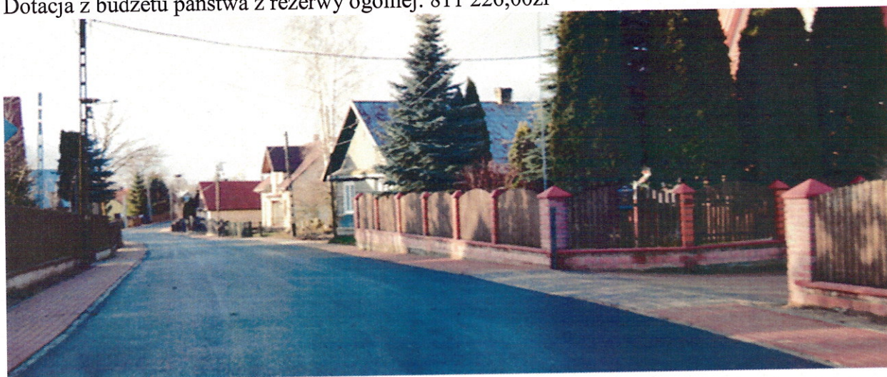
Droga nr 1266 B po przebudowie
