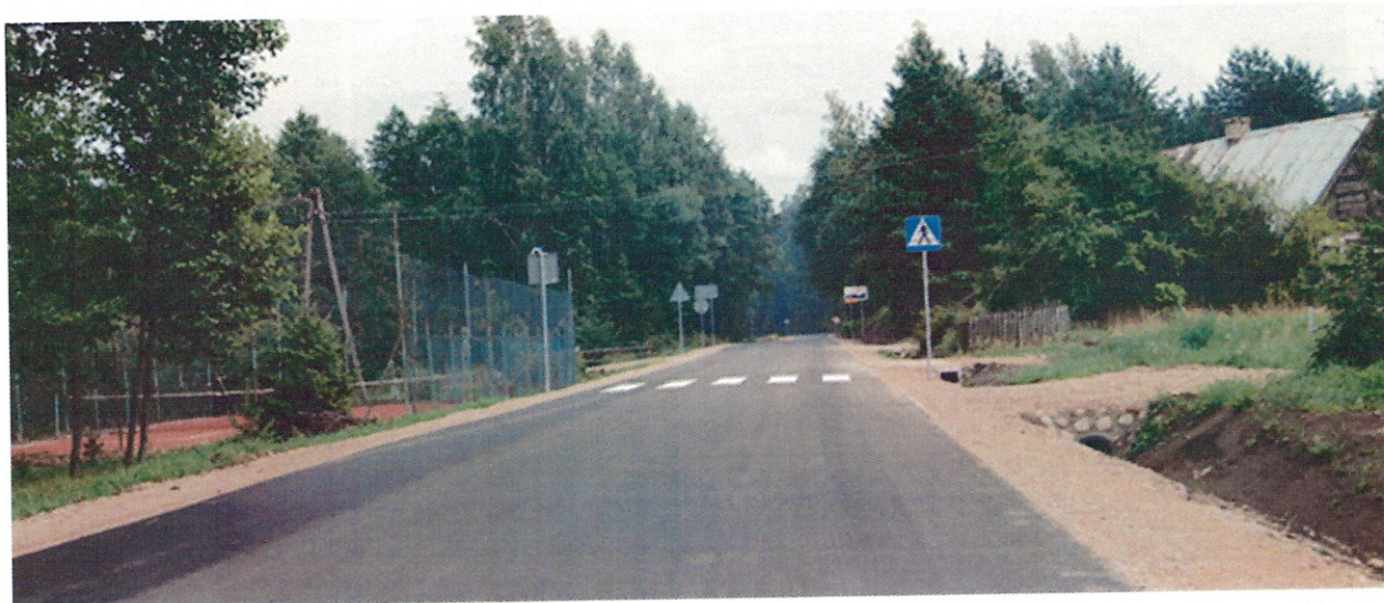
Droga nr 1338 B po przebudowie
