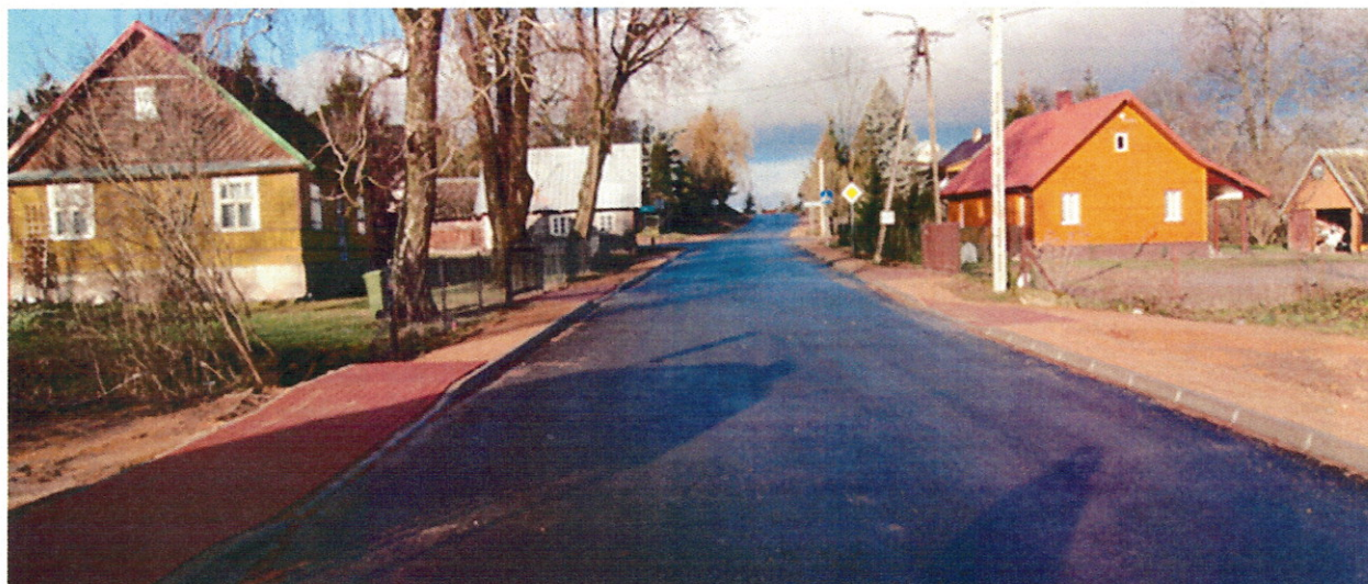
Droga nr 1267B po przebudowie
