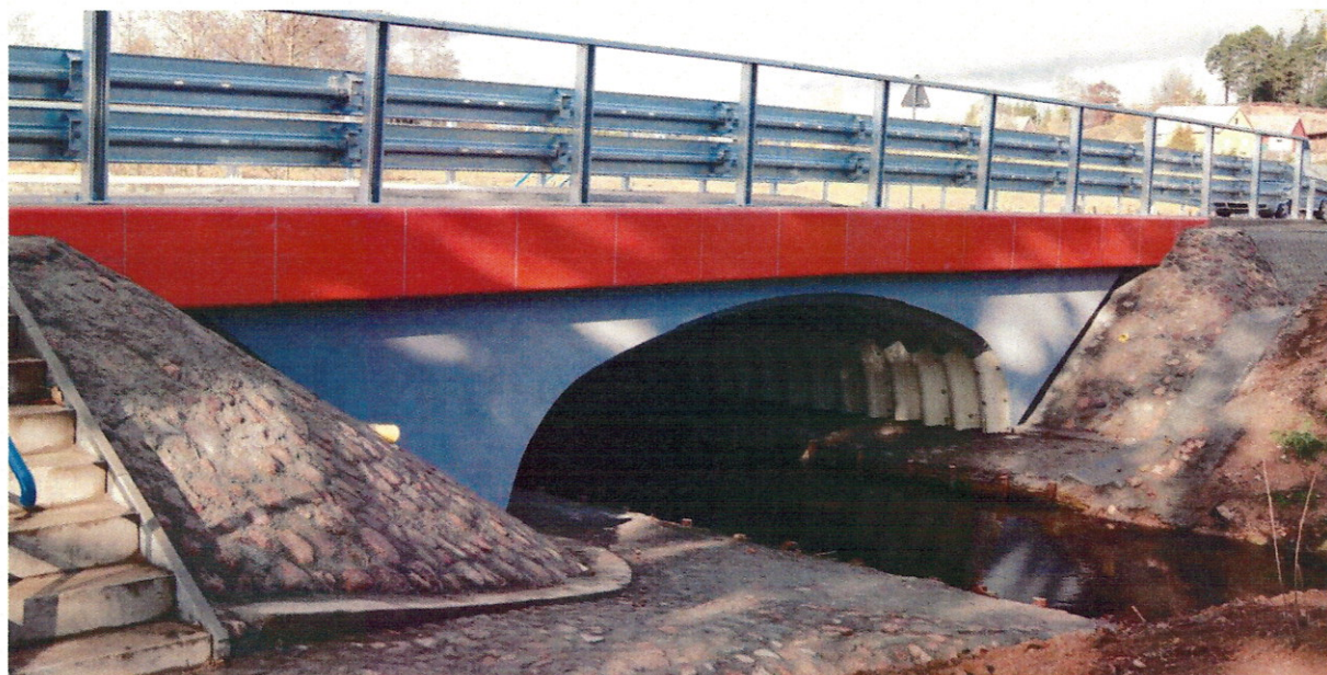
Most w Żukach po przebudowie
