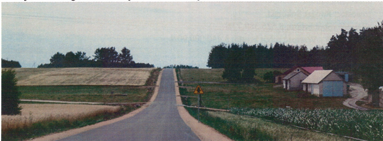
Droga nr 1240B po przebudowie
