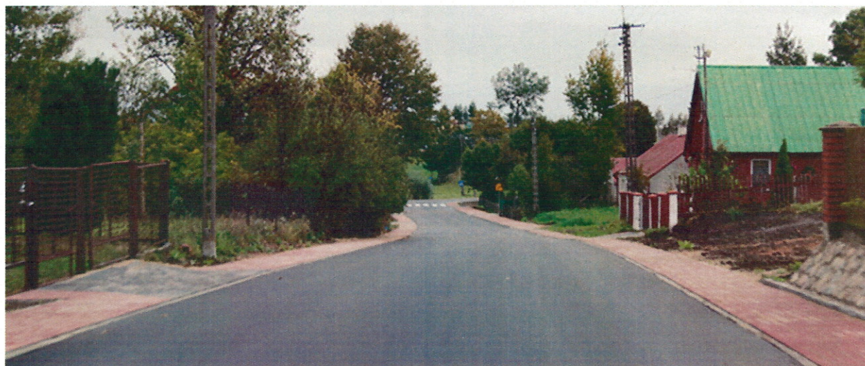
Droga nr 1247 B po przebudowie
